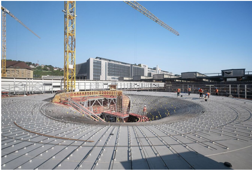
Einzelabstandhalter auf der Schalung der Kelchstützen © Bahnprojekt Stuttgart-Ulm, Foto: Achim Birnbaum
