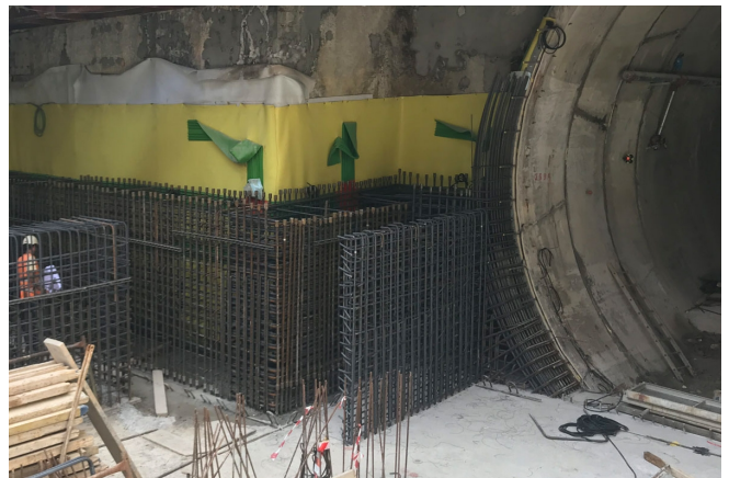
MAX FRANK Couplers installed before first pour © www.maxfrank.com
