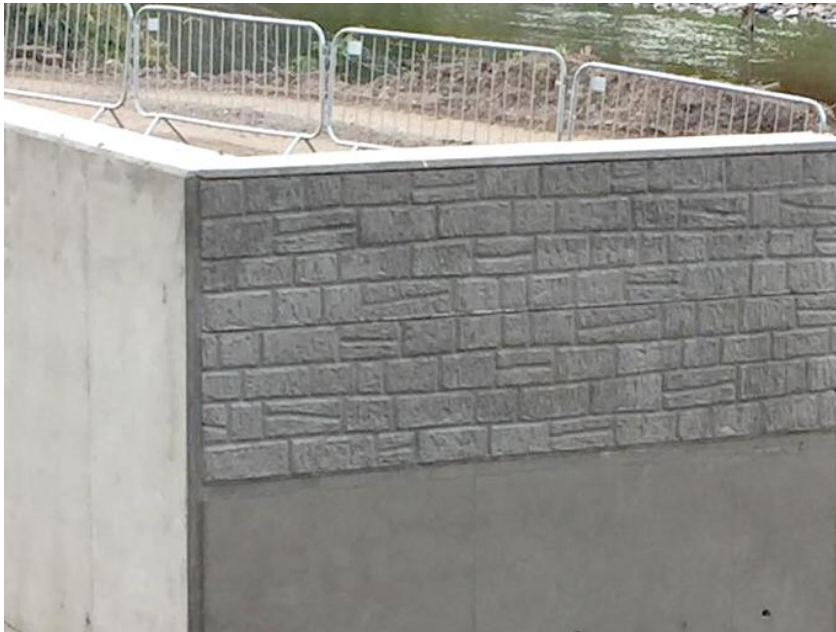
Oberflächengestaltung mit Insitex® Schalungsmatrize © www.maxfrank.com
