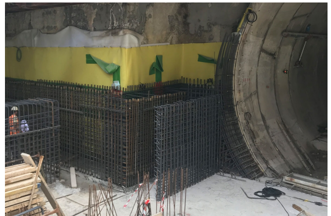
MAX FRANK Couplers installed before first pour © www.maxfrank.com
