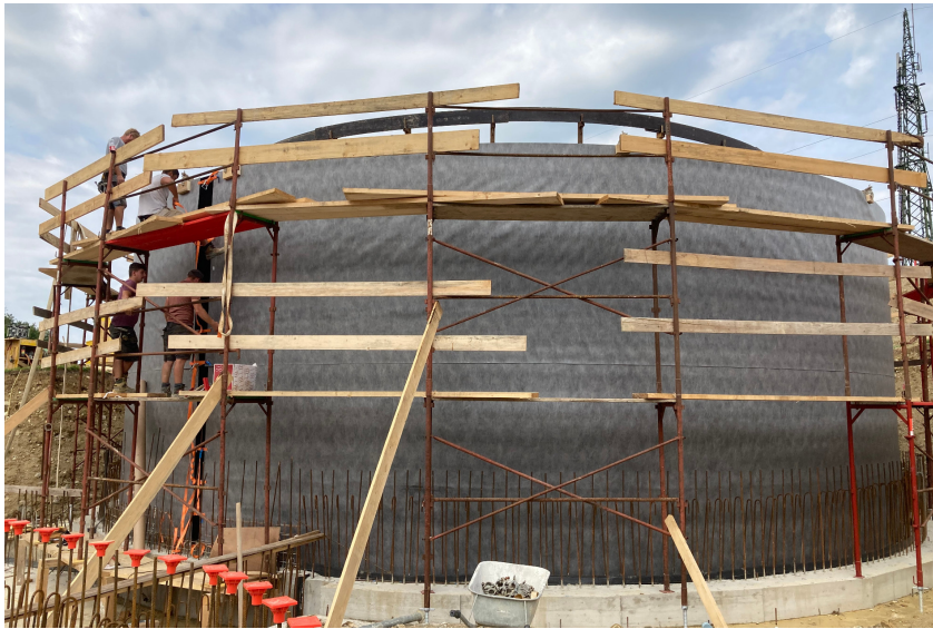
Trinkwasserbehälter Henndorf mit Zemdrain® Schalungsbahn
