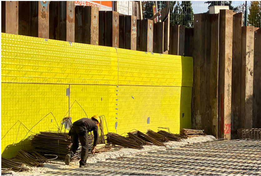
Universal-Schalmaterial Pecafile® Baugrubenverbau © www.maxfrank.com
