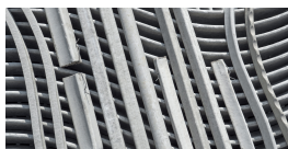
Afstandsstykker af fiberbetonstænger
