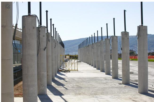
Schalrohr Tubbox® Oberfläche lunkerfrei
