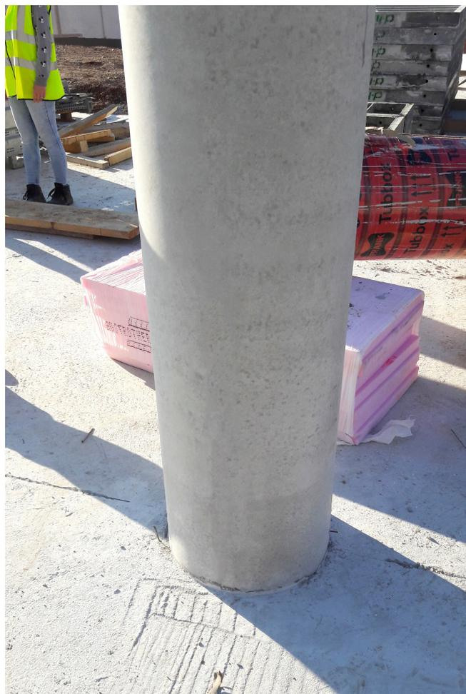
Schalrohr Tubbox® Oberfläche lunkerfrei
