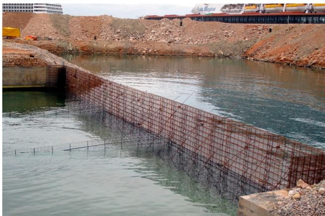
Abstellelement Stremaform® für Unterwasser-Betonage
