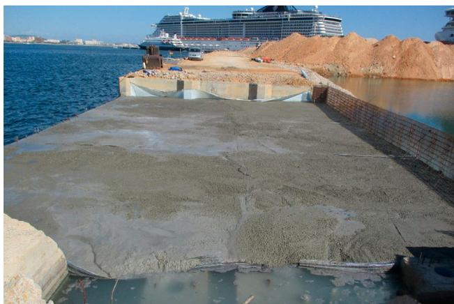
Betonage gegen vorgefertigten Senkkasten
