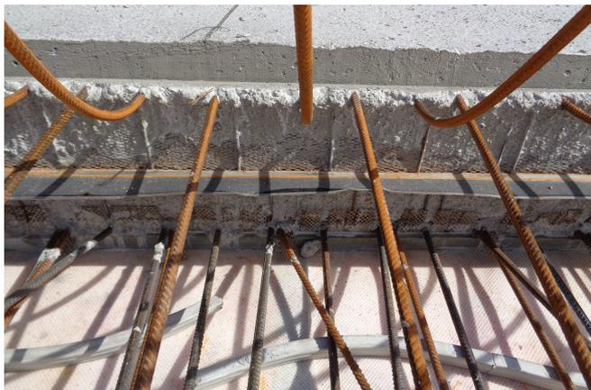
Arbeitsfugenabstimmung Stremaform® mit Fugenblech
