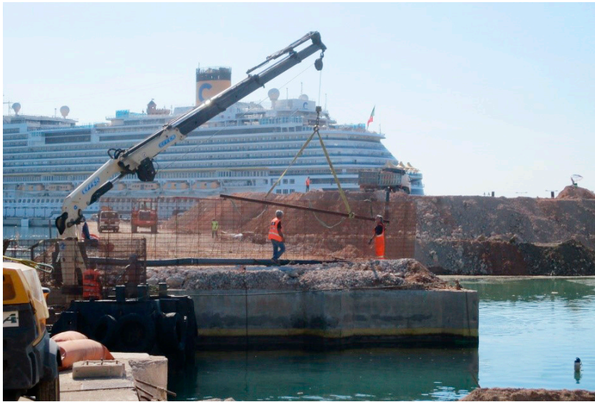
Platzierung der Abstellelemente mit herkömmlichen Hebemitteln © www.maxfrank.com
