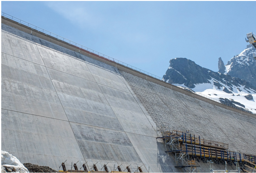
Staumauer Großer Mühldorfer See, teils mit neuer Betonvorsatzschale
